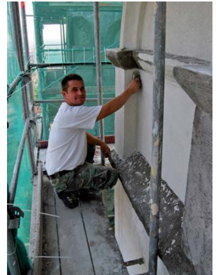
Putzarbeiten am Turmmauerwerk
