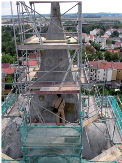
Putzsanierung an den zu verblechenden Bereichen
