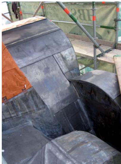
Aufwändige Konstruktionen dienen dem kontrollierten Sammeln und Abführen des Regenwassers
