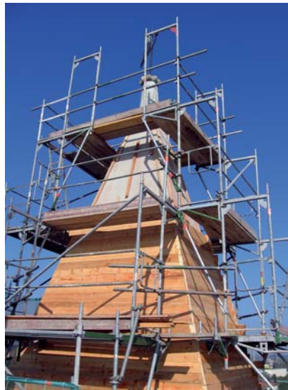
Holzschalung auf Lattung in Lüftungsrichtung
