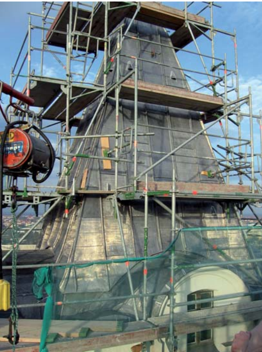
Fertige Bleistehfalzdeckung am Nordturm
