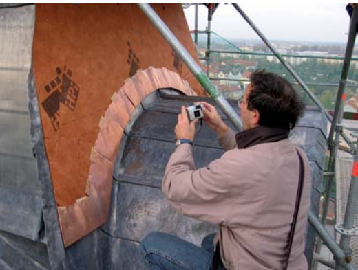
Dr. Heinecke inspiziert den Stand der Arbeiten
