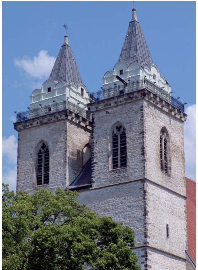
St. Johannes mit den fertigen Turmhelmen und saniertem Mauerwerk
