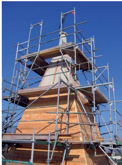
Holzschalung auf Lattung in Lüftungsrichtung
