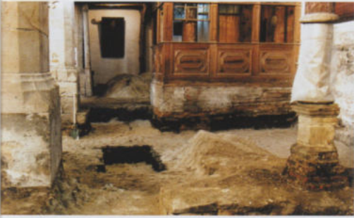
März 2004: Bauwerkstemperierung und Fußbodensanierung
