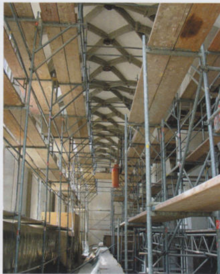
Fertigstellung der Gewölbesanierung im Herbst 2001
